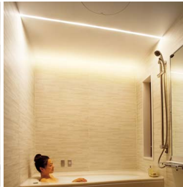
全灯(フラットラインLED照明+ウォールラインLED照明)
